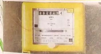
Este aparato es utilizado por la empresa de energía eléctrica para calcular el consumo de electricidad de una vivienda. Es un disco de aluminio que gira a una velocidad que depende de la cantidad de energía consumida.
