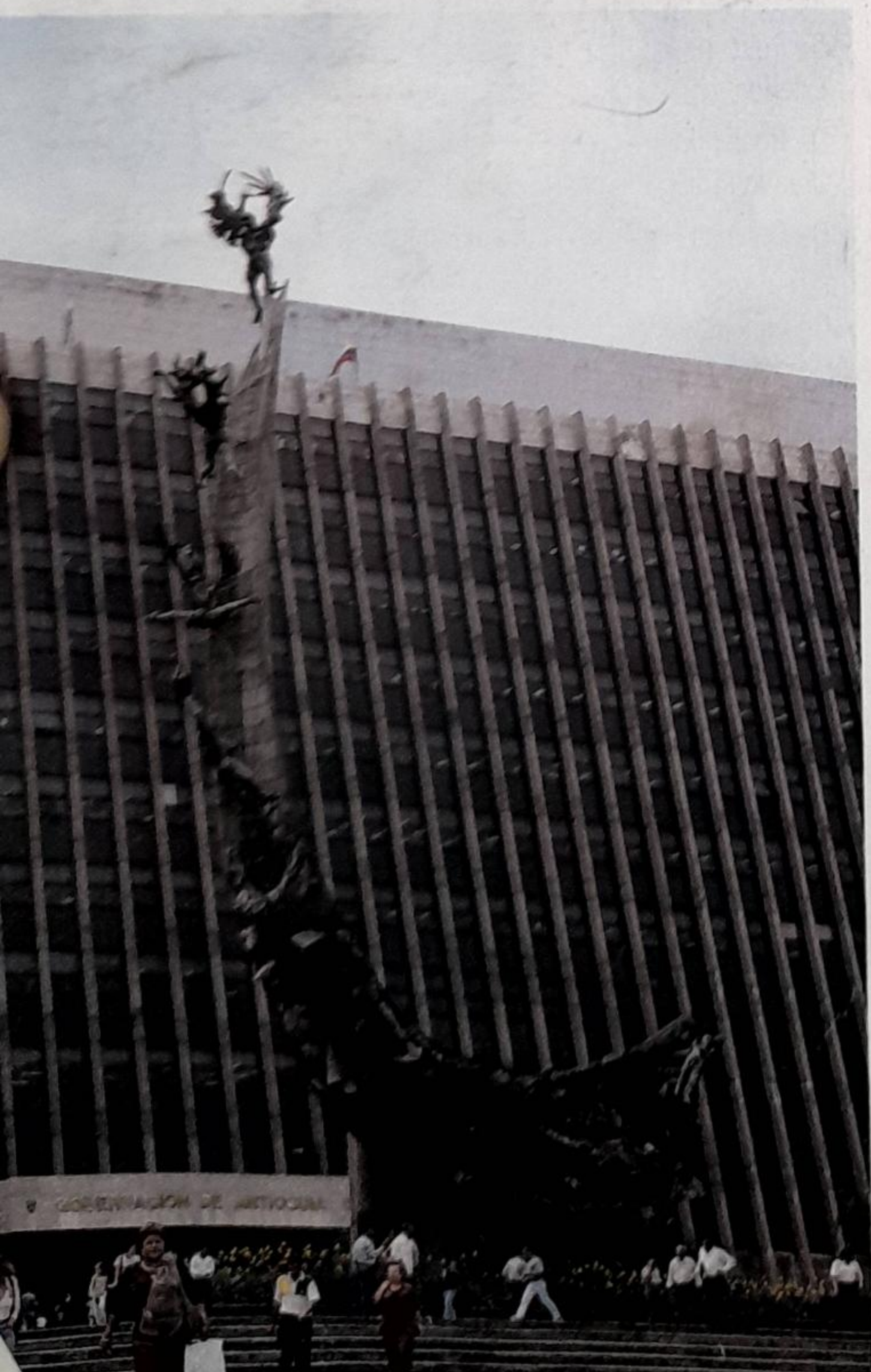
Fachada de la gobernación de Antioquia, en la ciudad de Medellín.
