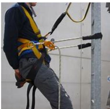
Es de uso obligatorio en todos los trabajos en alturas en que no existan plataformas de trabajo estructurales seguras, dotadas de sus respectivos barandas y rodapiés, por lo cual se empleará en trabajos en andamios colgantes o de secciones, en puestos de trabajo que den a un vacío, en trabajos en estructuras de soportes de cubiertas, limpieza de vidrios, mantenimiento de lámparas, cuando su altura lo amerite.
